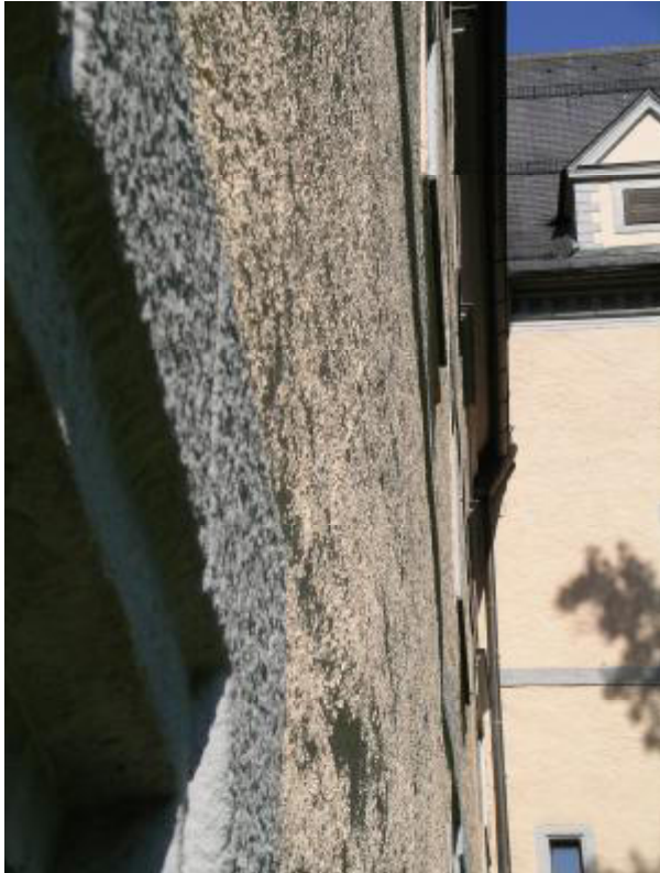
Blick Ostfassade aufwärts – Greinburg 2006
