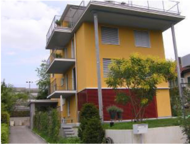
Bild 3 : Einsatz hydrophiler WDVS in Zug / Schweiz
