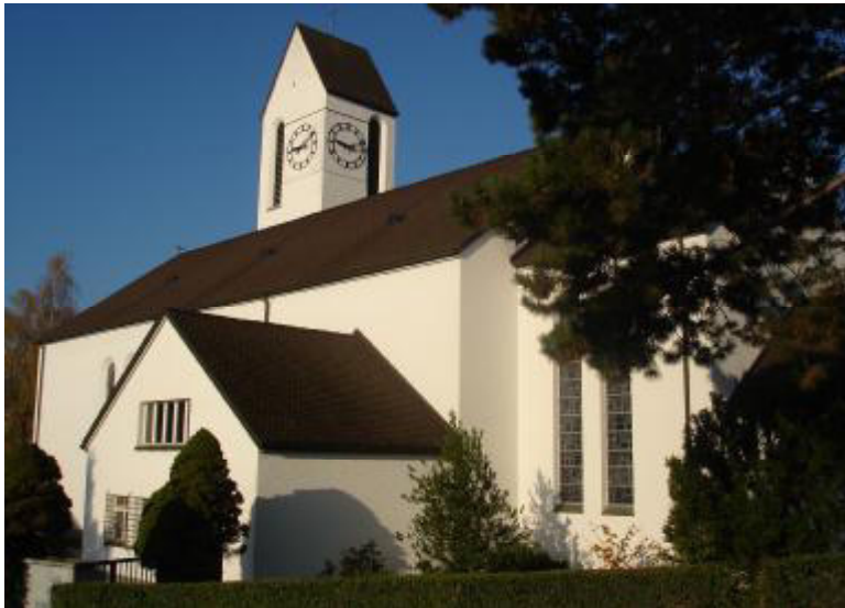
Bild 1: Kath. Kirche Birmenstorf – 16 Jahre Silikatfarbe auf Dickschichtputz
