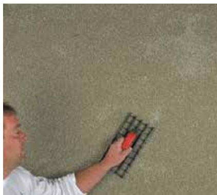
Abb. 1: Robottieren eines Innendämmputz (Foto: Heck Wall-Systems GmbH)
