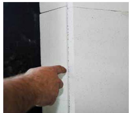
Abb. 2: Applikation eines Innendämmsystems (Foto: Keimfarben GmbH)
